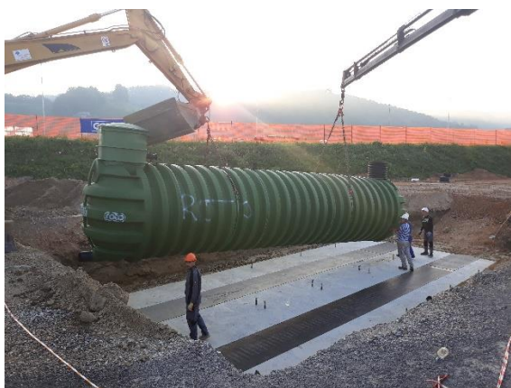
Afbeelding 4: Installeren van de tank
