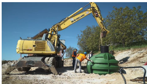
Afbeelding 3: Installeren van de tank
