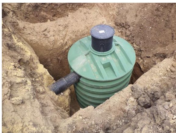
Afbeelding 6: Geïnstalleerde tank
