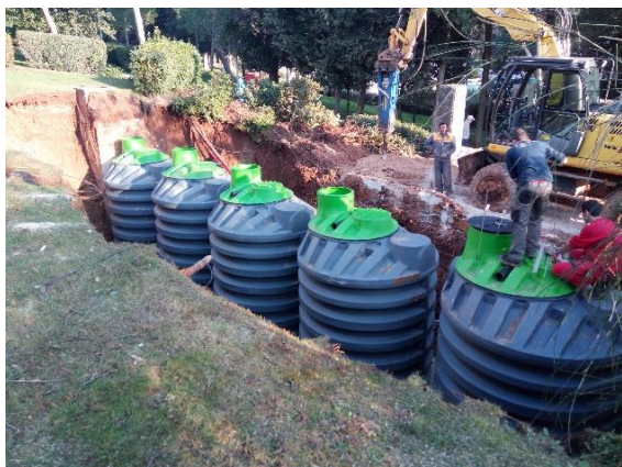
Afbeelding 5: Geïnstalleerde tanks op een rij
